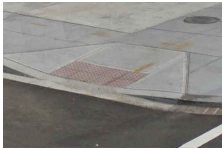
6 EXISTING ADA RAMP
